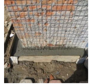
जगको तहमा बाहिरबाट ९ इन्चको टाईविमको लागि जगको नाप जाँच गर्दै । तस्विर: यूएसएआईडी/मेरो सुरक्षित गाउँ
