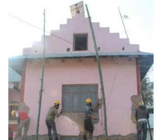
मह्यालको मुनि राखिने तेर्सो पट्टीको लागि सतह सफा गर्दै । तस्विर: यूएसएआइडी/मेरो सुरक्षित गाउँ
